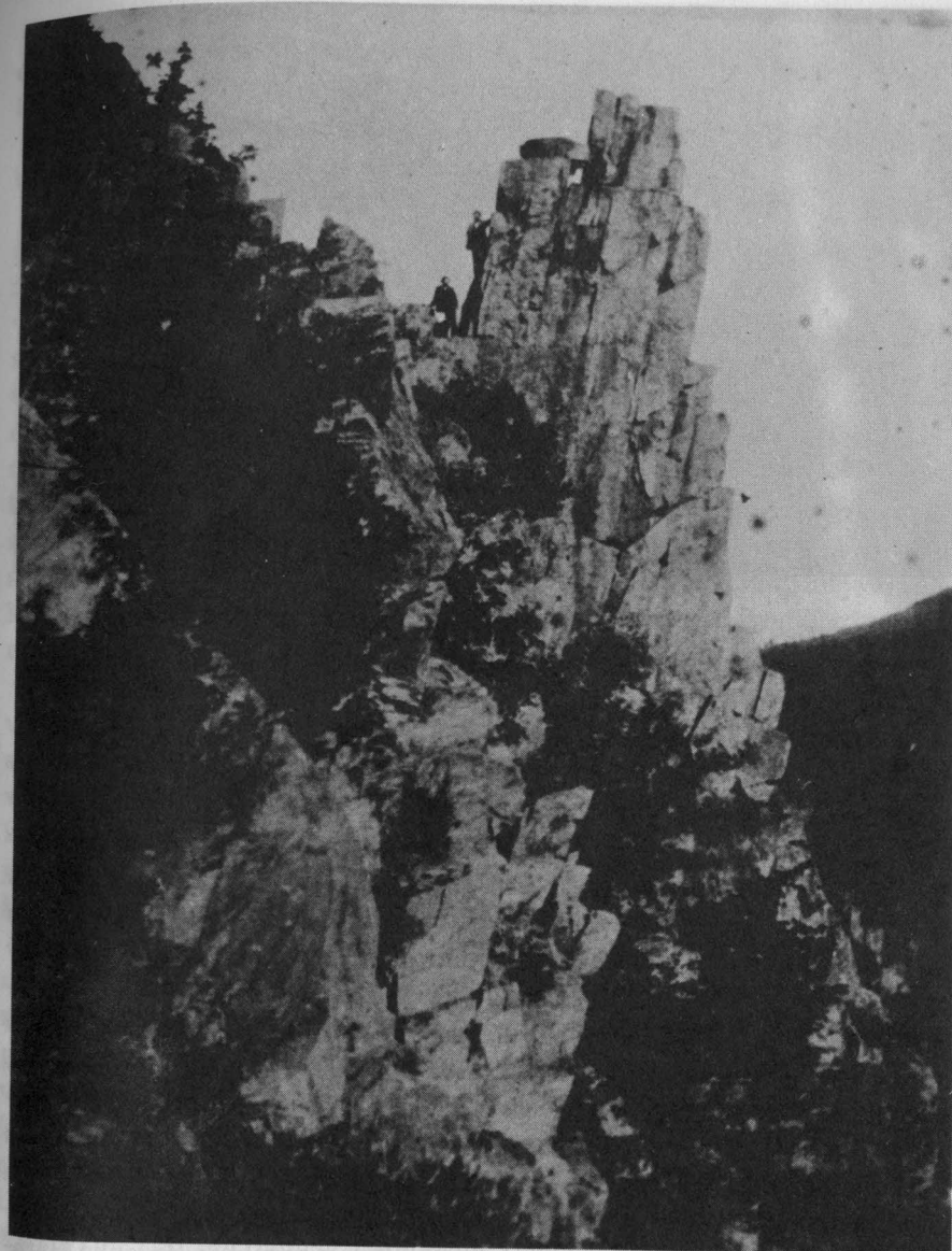
Vyměřování trati v km 25,8 v roce 1896 Foto archiv M. Berka
