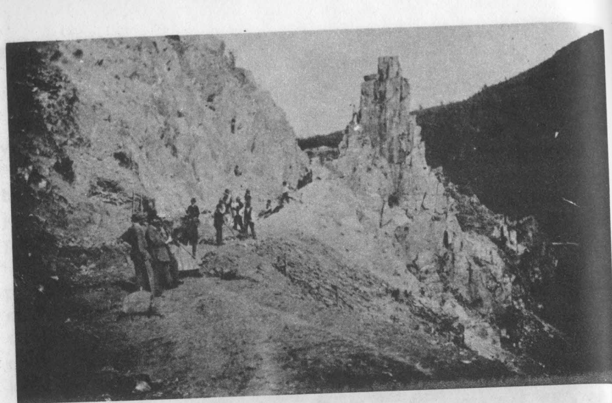
Stavba zářezu trati v km 28,8—25,9 v r. 1898 Foto archiv M. Berka.
